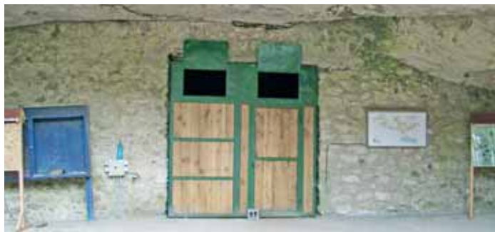
Ranije uobičajena praksa zaziđivanja ulaza pećina, neprihvatljiva je, jer menja mikroklimu što dovodi do izumiranja ili velikih promena pećinske faune (Lazareva pećina, istočna Srbija)
