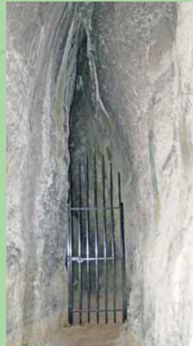
Rešetka na ulazu Hadži-Prodanove pećine omogućava nesmetan prolaz slepih miševa u gornjem delu ulaza, a sprečava nekontrolisan pristup ljudi
