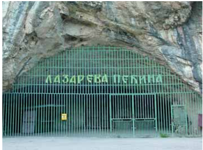
Rešetka na ulazu u Lazarevu pećinu pre uklanjanja vertikalnih šipki u gornjem delu nije omogućavala prolaz slepim miševima
