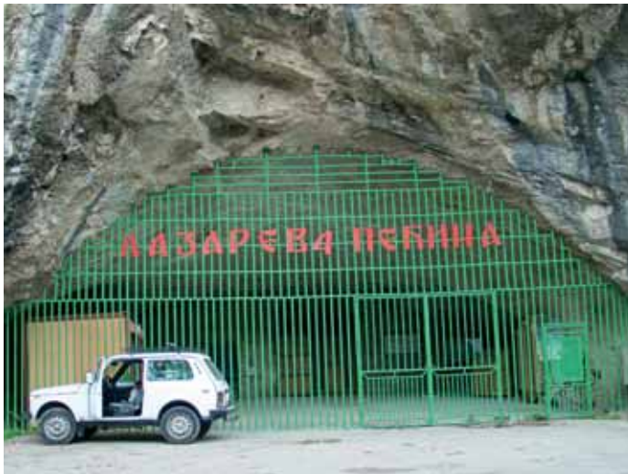
Rešetka na ulazu u Lazarevu pećinu nakon uklanjanja vertikalnih šipki u gornjem delu omogućava prolaz slepim miševima
